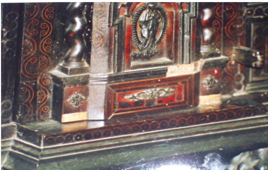
Detalle frontal antes de la intervención.
